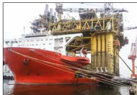
Super-levage et pose synchronisés
